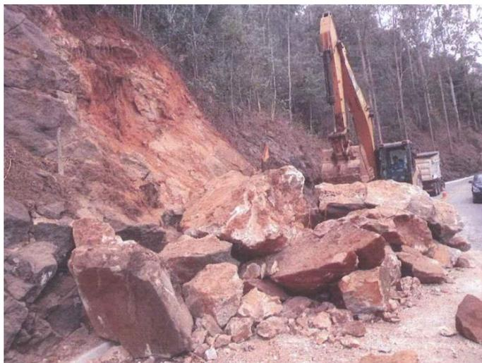
*Figura 6.18 Rota 116 – Contenção de Encosta – Remoção de blocos soltos – serviços preventivos Km 74 N*
