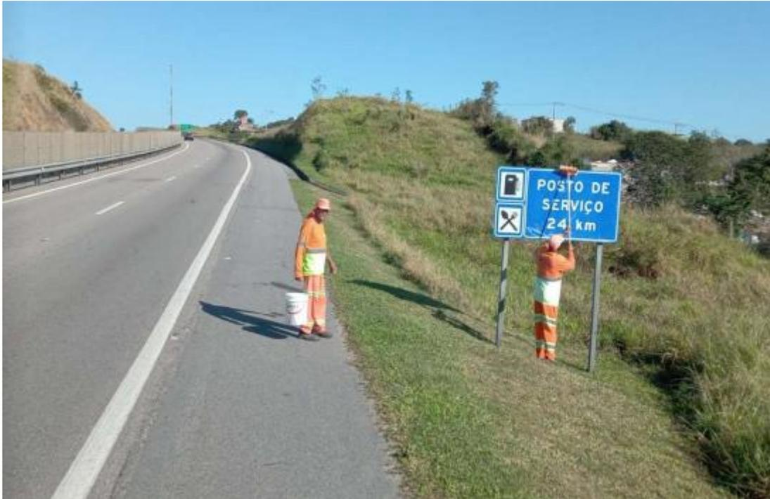
*Figura 4.7 Via Lagos – Limpeza de placa – Km 56+000 Sul*
