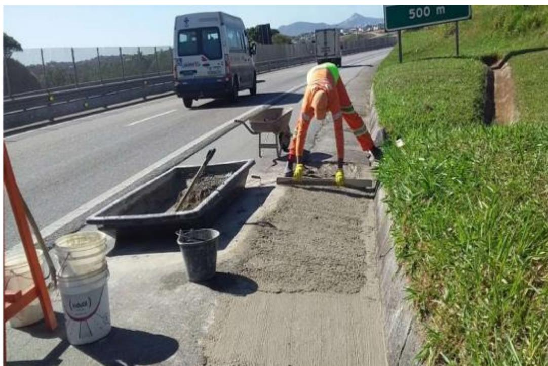
*Figura 4.12 Via Lagos – Recuperação de sarjeta – Km 56+000 Norte*
